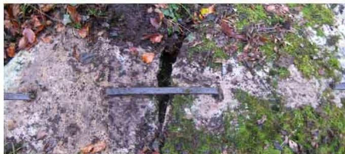
Fig : en rive gauche, 3 dalles de couverture de la crête du seuil, maintenues par des agrafes métalliques, sont visibles.
