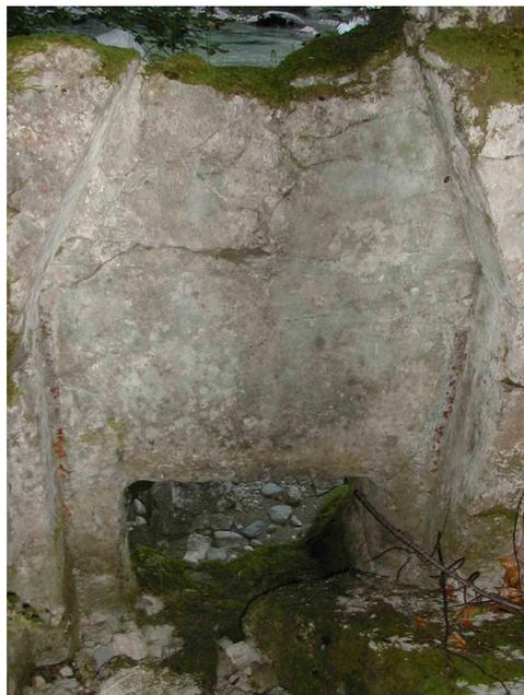
Fig : réseau hydraulique de la scierie : la vanne de dégrèvement vue côté canal avec sa forme en trapèze dans la partie supérieure recevant la vanne en position ouverte.
