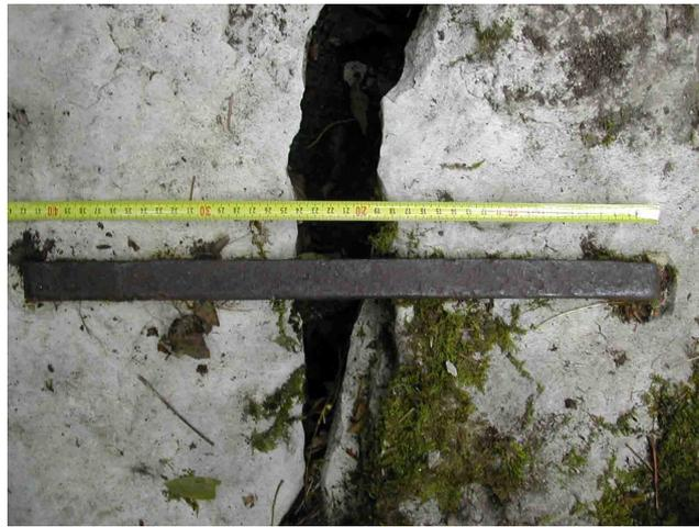
Fig 6 : en rive gauche, l'unique agrafe existante sur le crête du seuil.
