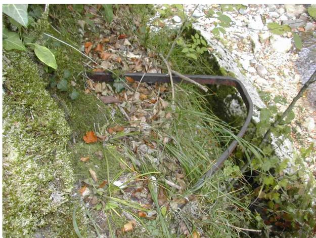
Fig 3 : en rive gauche, fixée sur le talus rocheux vertical contigu au seuil, l'agrafe C en « U »
