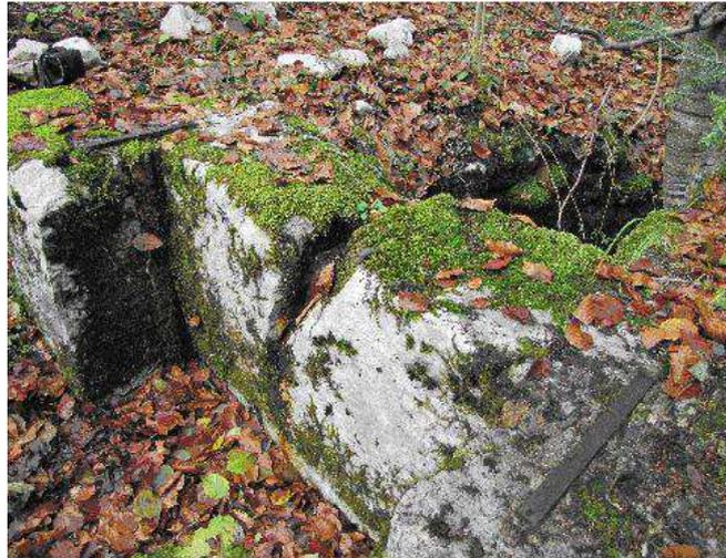
Fig 2 : en rive gauche à la vanne de l'orifice de la prise d'eau en rivière, les deux agrafes *B*
