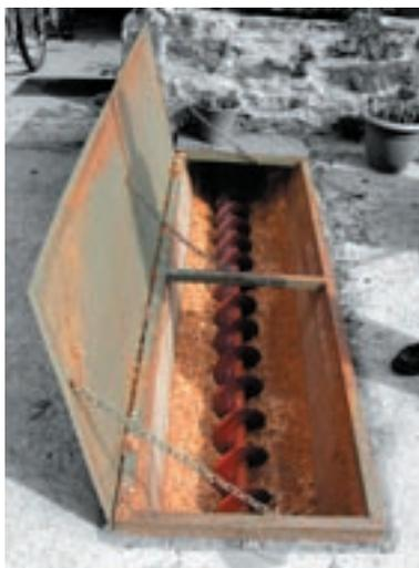
Trappe d'alimentation du silo de la chaufferie, avec 'vis sans fin'
