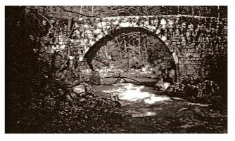
notamment en rive gauche, du fait des ruissellements d'eau mal canalisés venant de la forêt. Des travaux d'urgence doivent être rapidement réalisés.
