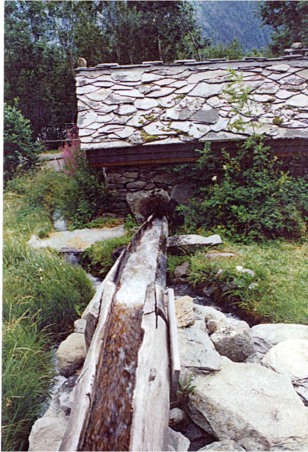
Fig 7 : béal en bois réalisé avec des troncs d'arbres évidés posés sur le sol ou des pierres (à Pralognan - Alpes) (photo Mestrallet D.)
