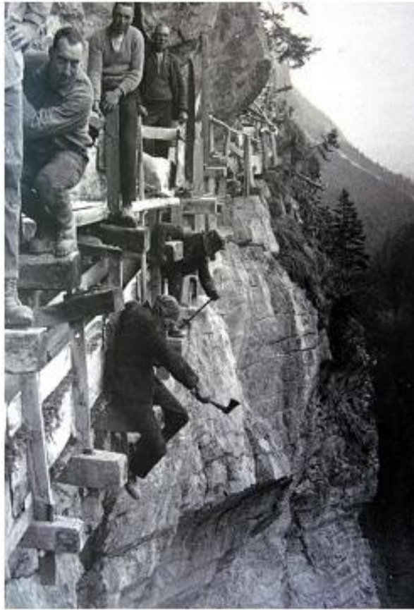
Fig 15 : la construction et la pose d'un béal (bisse) en bois accroché sur le flanc vertical d'une falaise se faisait par une équipe dont les membres n'avaient ni le vertige, ni le sens de la sécurité du travail ! (Valais, Suisse).
