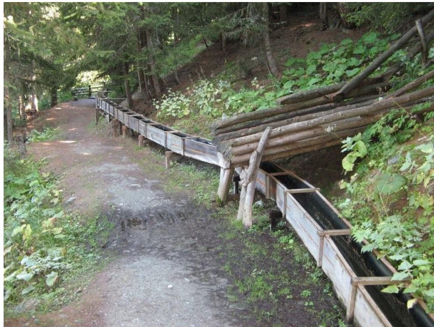
Fig 8 : béal posé sur le sol avec des chevalets plus ou moins hauts
