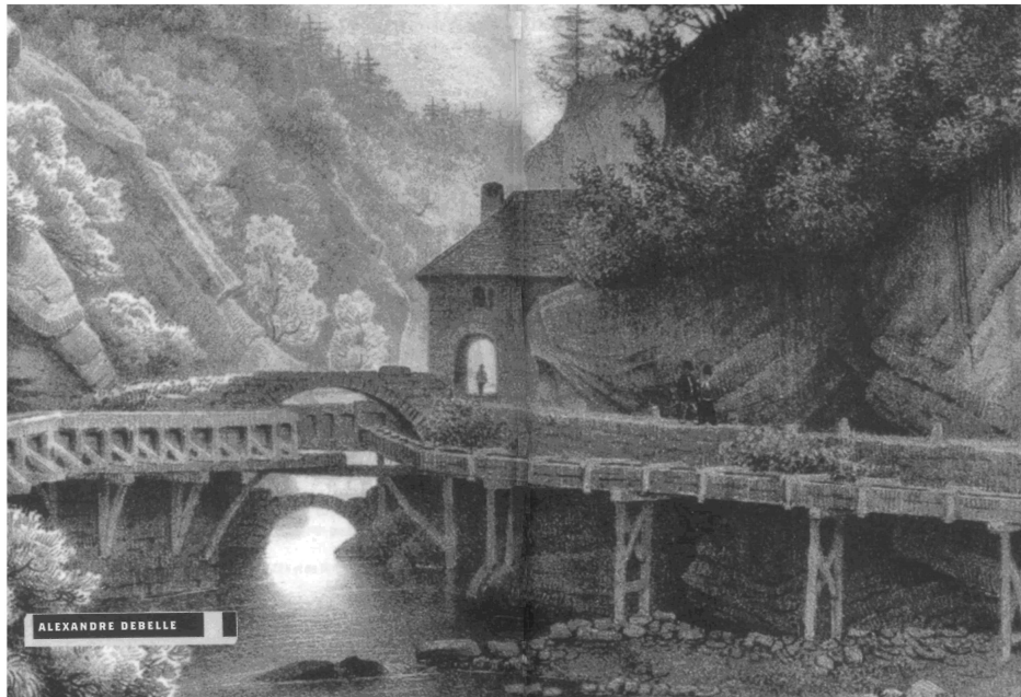
Fig 13 : les réseaux de béals en bois à Fourvoirie (vallée du Guiers mort) en 1830. Voir également la figure 12.
