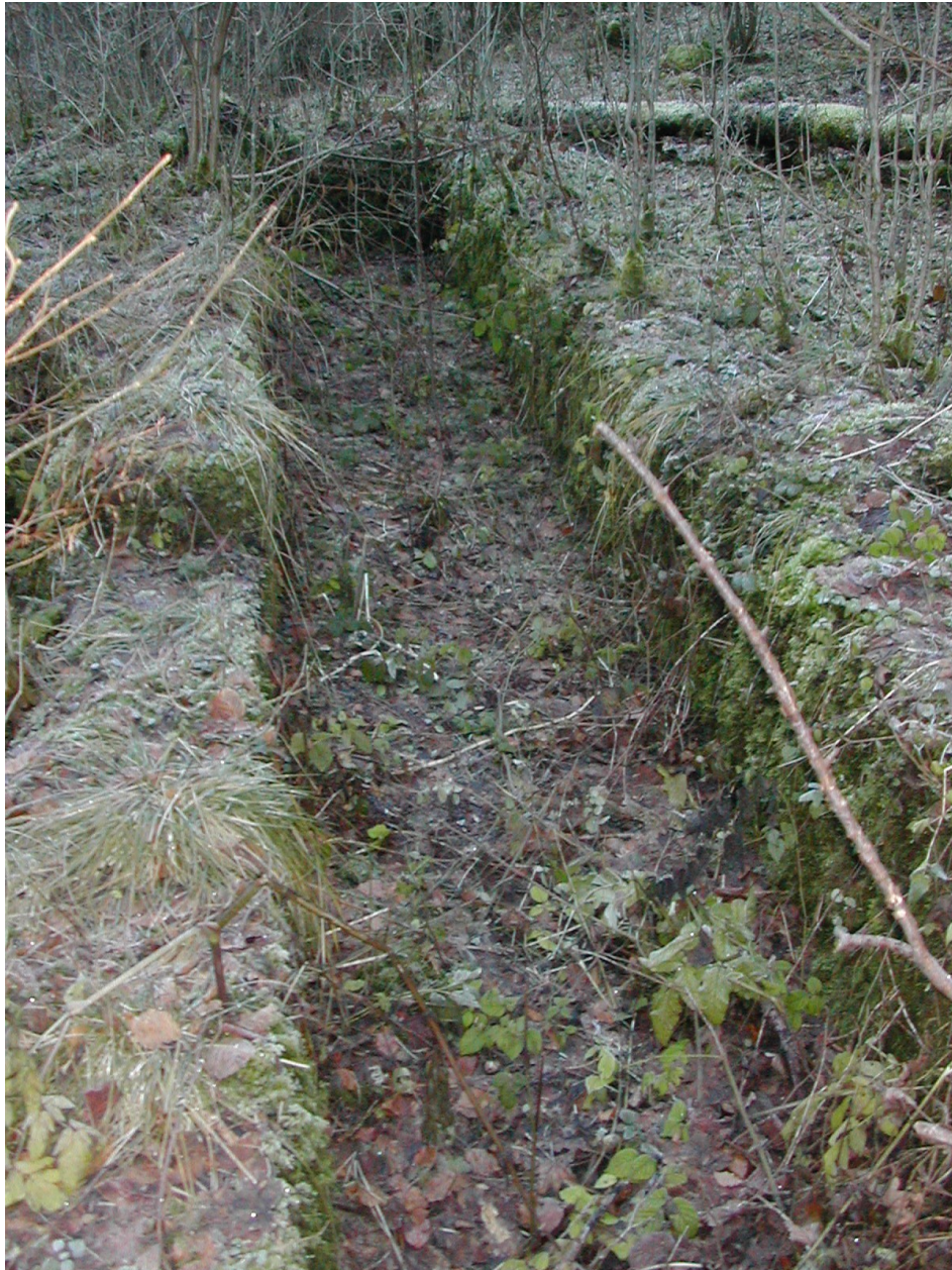
Fig 6 : terminaison aval du canal construit en blocs de calcaire parallélépipédiques posés au ras du sol. Le déversoir latéral D (voir dessin précédent) est visible à gauche (rejet du canal au Guiers car le mur aval du canal servait à alimenter des scieries au XIXe siècle).
