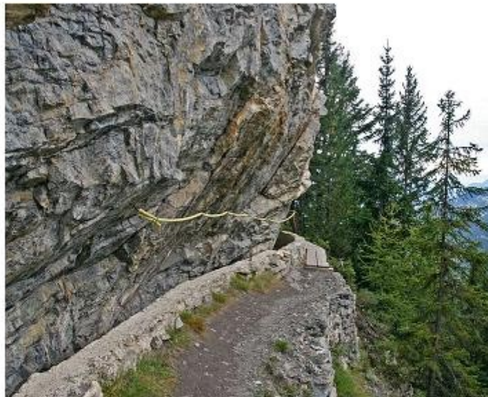
En Suisse, bisse à flanc de montagne, creusé dans le rocher
