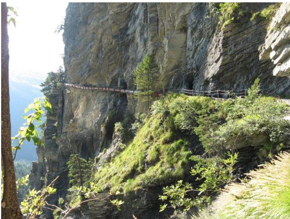
Fig 14 : bisse à flanc de falaise dans le Valais (Suisse). Ces réseaux impressionnants sont très longs. Cités dès le XIII e siècle, ils transportaient l'eau de fonte des glaciers.
