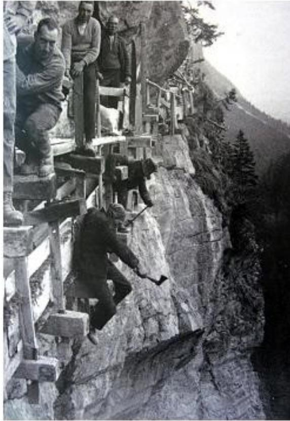
Fig : construction d'un *buisse* dans le Valais suisse. Un *buisse* est un *béal* assurant le transport des eaux de fonte des glaciers. De nombreux et longs tronçons étaient construits à flanc vertical de falaise. L'image montre qu'en oubliant les principes élémentaires de sécurité un tel travail était possible (au prix de combien de chutes mortelles ?)
