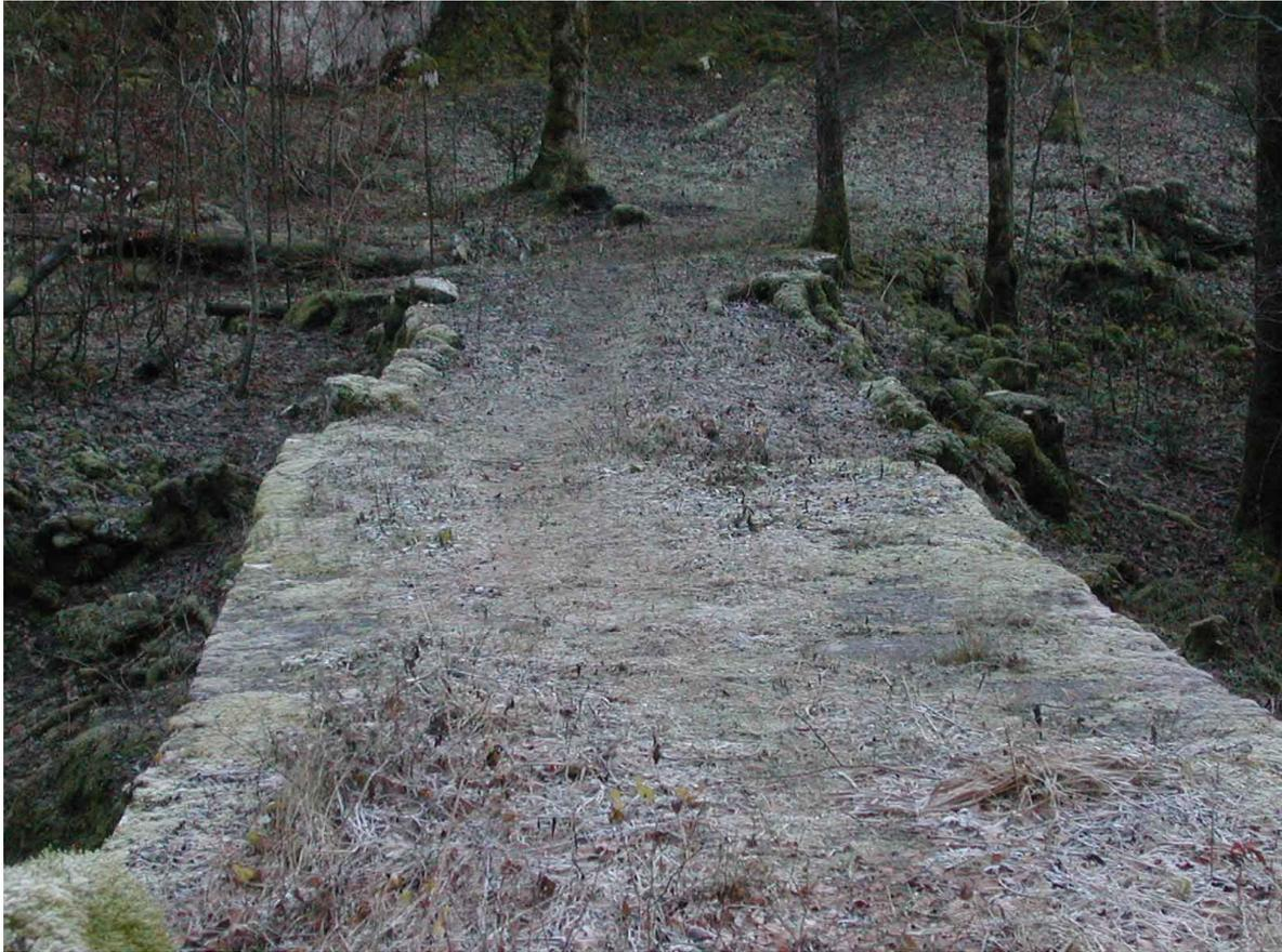
Fig : le pont du martinet sur le Guiers mort (vue sur la rive gauche où une rampe complémentaire et plus tardive est visible). Construit au XVII<sup>e</sup> siècle il fut précédé par une passerelle en bois. Il ne comprend pas de parapets, alors que la largeur du tablier n'est que de 3,2 mètres. (massif de la Chartreuse).
