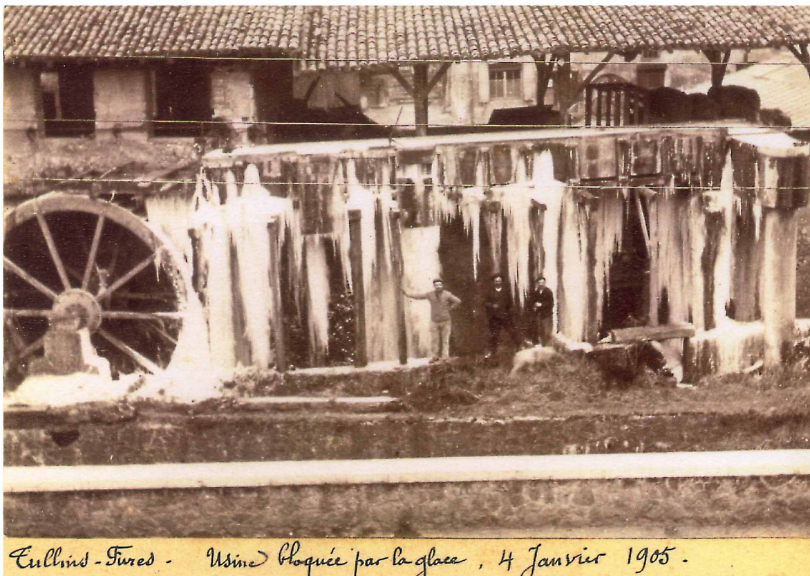
Fig : béal et roue hydraulique de 5 mètres de diamètre à la papeterie Guély, à Fures, bloqués par les glaces (b40).
