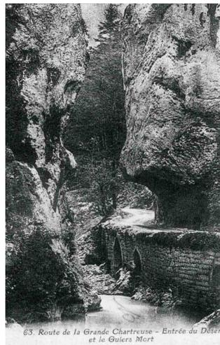
Fig : la sortie des gorges ou *l'étréit de Fourvoirie*, RIVE GAUCHE : vue de la rive gauche, dans les gorges de Fourvoirie en basses eaux. La largeur du lit est très faible. *Le chemin des voûtes* est établi sur un remblai (après excavation des rochers) maintenu par des arcs en pleins cintre.
